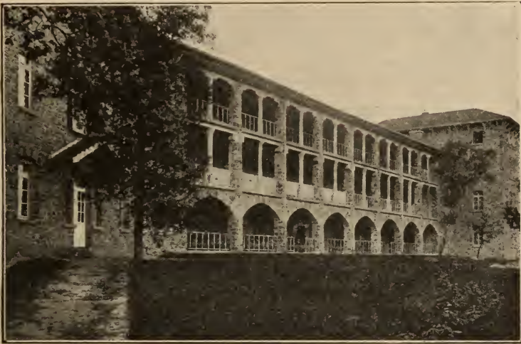
Fig. 102. — Galerie de cure. Pavillon des femmes à Bligny. (Guinard.)
